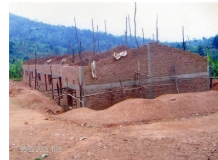
Feb. 2008 la muratura è terminata
