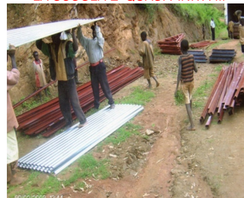
29 Febbraio 2008. È arrivato il tetto. LA SCUOLA E' QUASI FINITA !!!
