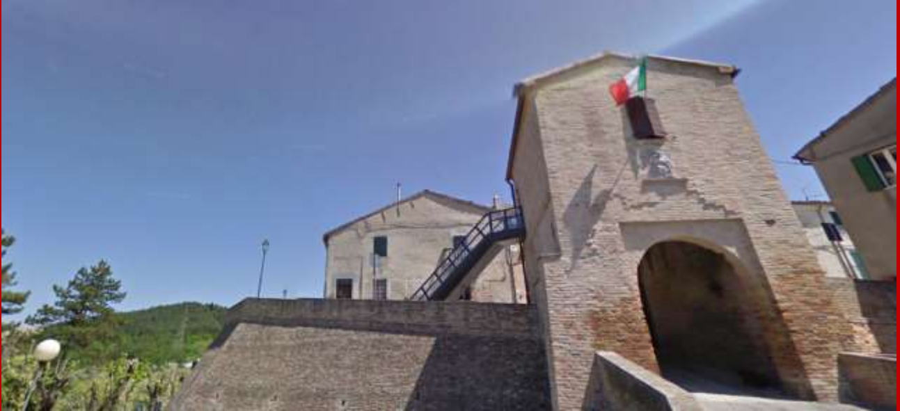
Sala del Cassero posta sopra la porta di ingresso della cinta muraria del paese di Montefabbri
