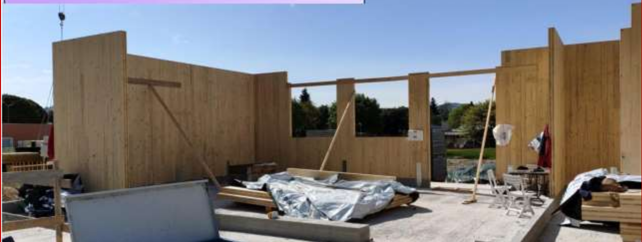
Posizionamento delle pareti in legno lamellare "Xlam"
