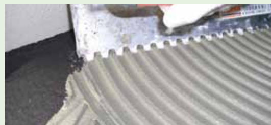
Sobre UNOLASTIC es posible colocar tablillas o tejas y fijarlas directamente sobre tiras de argamasa
