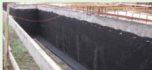
Proteger la impermeabilización con PROTEFON TEX o paneles PES
